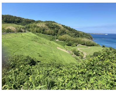
当田ダム付近
