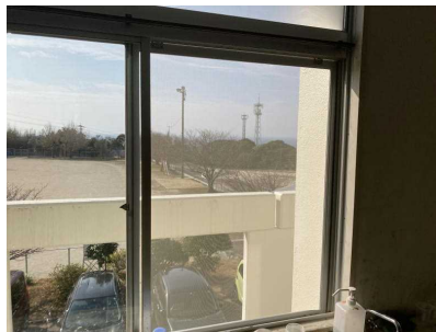
理科室・図工室の網戸の設置
